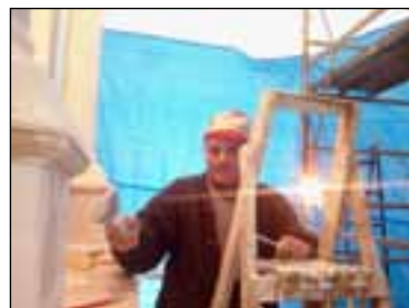
Durante i lavori alla Fonte battesimale
